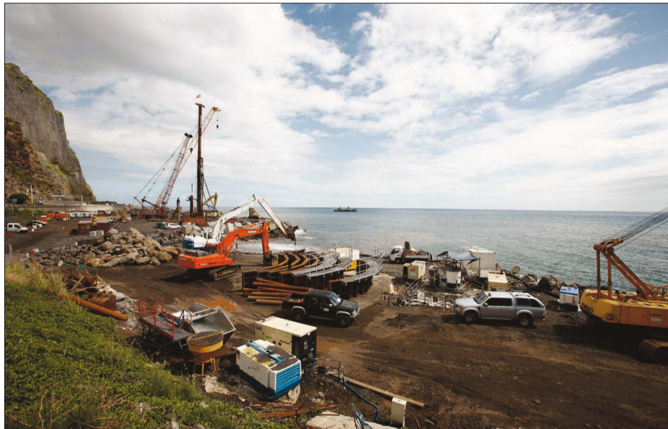
Beaucoup de jeunes issus du quartier de la Grande-Chaloupe espèrent intégrer le chantier de la nouvelle route du littoral (photo Ludovic Lai-Yu).
